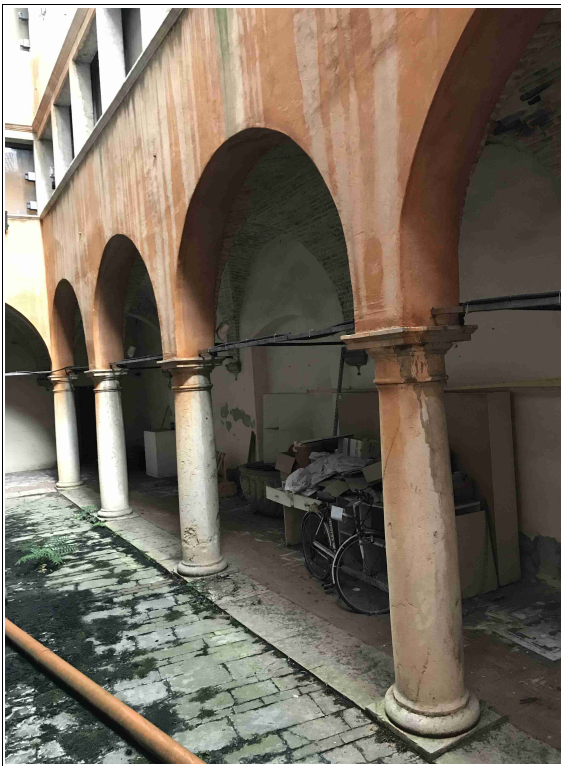
Cortile interno, fronte sud: effetti del dilavamento con fenomeni di dissoluzione della coloritura e deposito sulle colonne lapidee.
